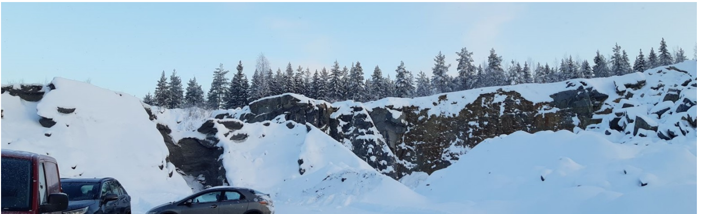
Kuva 2. Kuvan keskivaiheilla uloke, jonka pudottamisesta turvallisuussyistä keskusteltu aiemmilla tarkastuksilla, sijoittuu 300 metrin suojavyöhykkeen sisälle.
