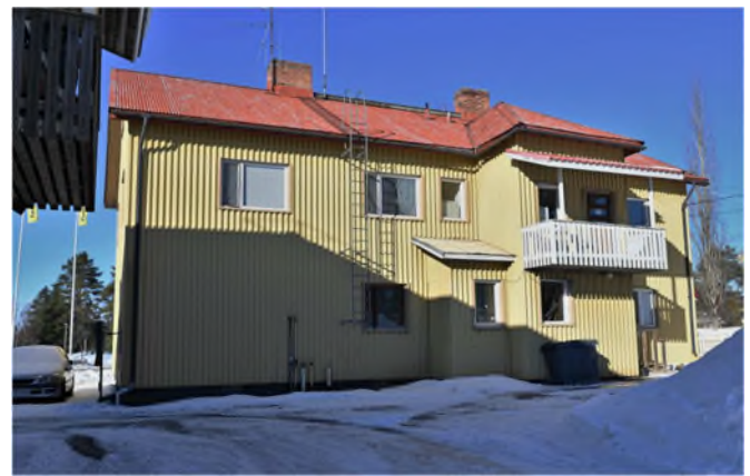
Kuva 56. Aunuksen pihan puoleinen julkisivu. Aukotukseen on tehty muutoksia. (T. Ahola, 2023.)
