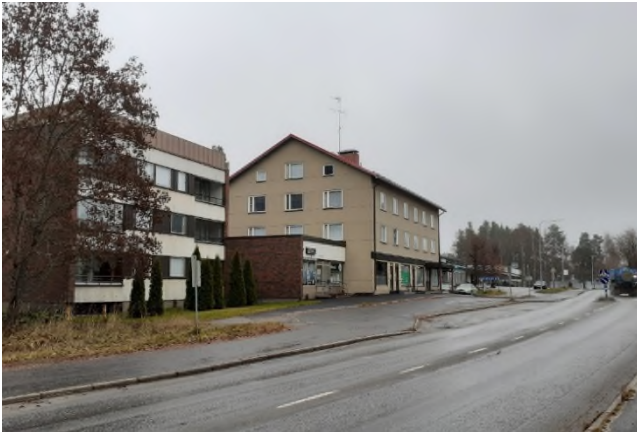
Kuva 41 (vasemmalla). Aseman seutu -kokonaisuuteen kuuluva Alanko-rakennus (ei sijoitu suunnittelu-alueelle). Keskellä alkuperäinen vuonna 1955 valmistunut harjakattoinen kerrostalo ja sen etupuolella 1960-luvulla rakennettu lisäsiipi.
