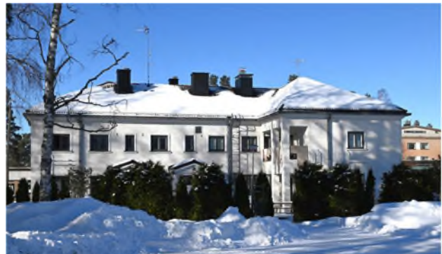
Kuvat 44 ja 45. Humina-rakennus, tunnettu myös Kivihovina. (Kuvat: T. Ahola, 2023.)
