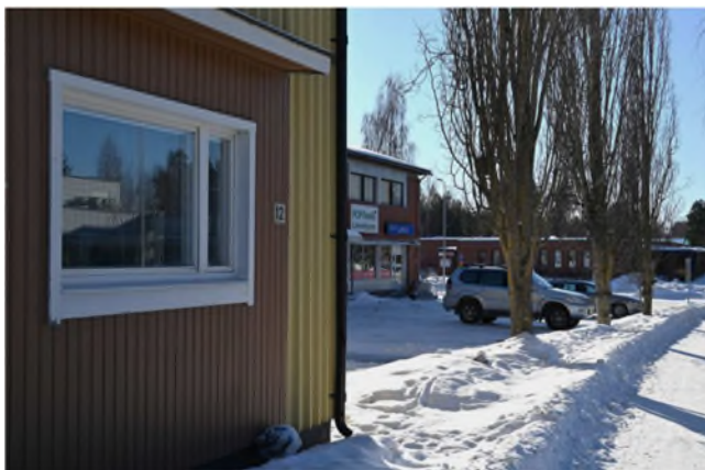
Kuva 55. Aunuksen talon käyttötarkoituksen muutokset ovat vaikuttaneet julkisivuihin. Muun muassa entisten liiketilöiden näyteikkunat on pienennetty katu-fasadista. (T. Ahola, 2023.)
