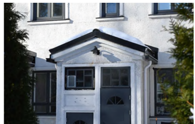
Kuva 46. Sileäpintaisia yksityiskohtia roiske-rappauksen rinnalla. Ovet on vaihdettu tehdasvalmistisiin standardioviin. (Kuva: T. Ahola, 2023.)
