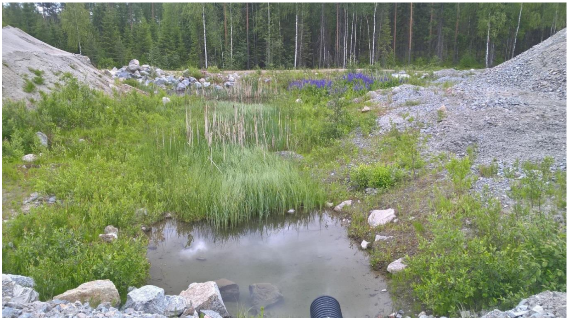
Kuva 5. Kosteikko kiinteistön Hienonen etelälaidalla. Kuvassa näkyvä putken pohjoispäästä otetaan tarvittaessa hienoainesta veden kulkeutumisen parantamiseksi ja kosteikon toimivuuden varmistamiseksi.
