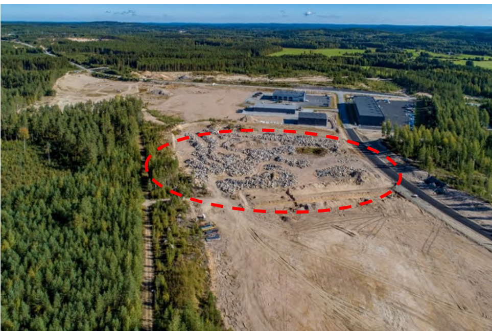
Kuva 5. Ilmakuva Sorajyvän yritysalueelta vuodelta 2022, jolloin alueen kunnallistekninen verkosto oli vielä rakenteilla. Suunnittelualueen likimääräinen sijainti on merkitty kuvaan punaisella.
