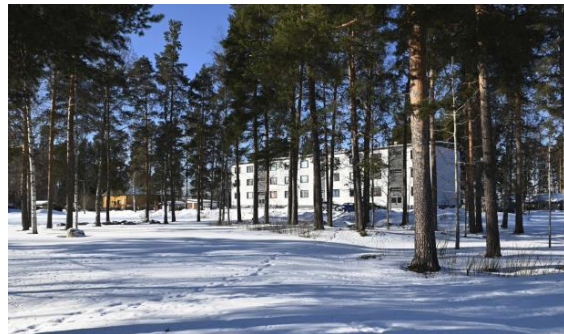
Kuvat 57 ja 58. Suunnittelualueella sijaitsevat 1970-luvun kerrostalot sekä niiden viereistä männikköä.
