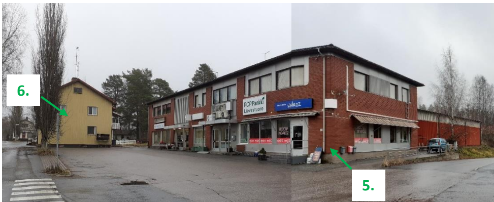
Kuva 31. Suunnittelualueen itäosassa Liepeentien eteläpuolella sijaitsevat liike-/liike-asuinrakennukset.
