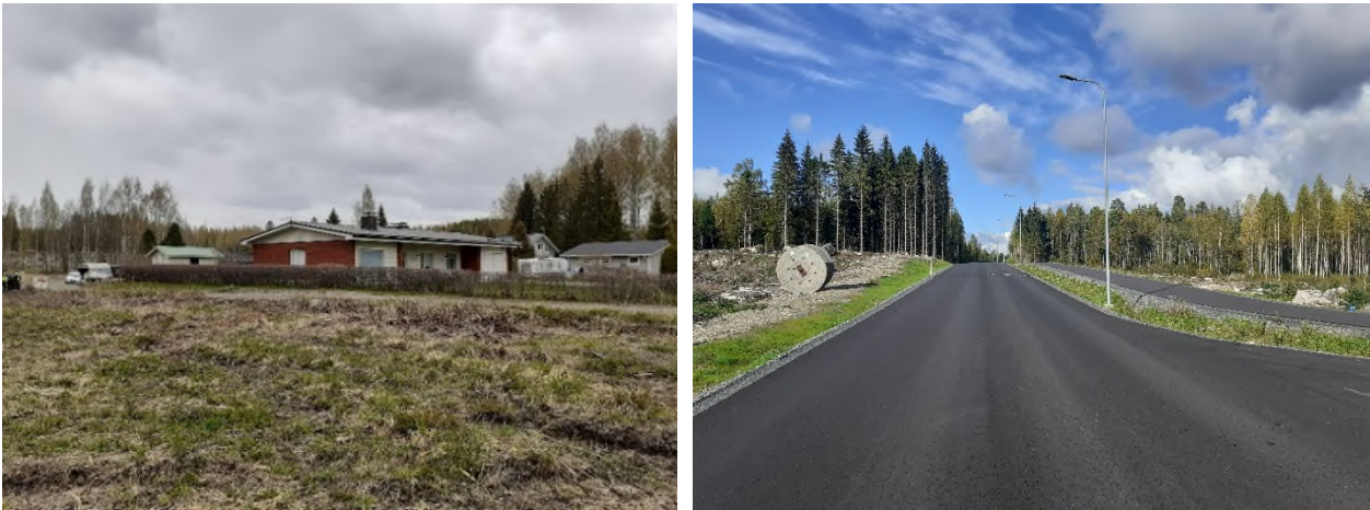
Kuvat 31 ja 32. Vasemmalla suunnittelualueella Kantolantien ja Venekujan varressa olevaa rakennuskantaa. Oikealla uutta Lahnajärvenkatua. Kaavan suunnittelualue sijoittuu kadun oikealle puolelle.
