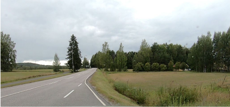
Kuva. Vesistöihin rajautuva alueen osa-alue 1 (Selvitystyö Ahola 2024).
