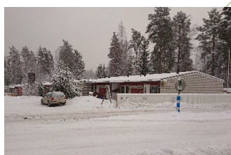
Kuva: Kerrostaloaluetta vastapäätä, Haaviston tien itäpuolella, on rivitaloalue, jonka vanhin rivitalo on valmistunut jo 1967, muutoin rakennuskanta on 1970- ja 80-luvuilta.
