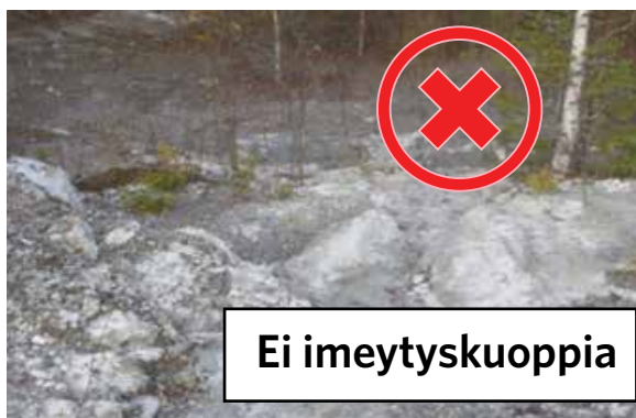
Kuva 5. Kuvassa liete valunut maastoon. Ylijäämäbetoni kuivatetaan kuivatustasolla ja toimitetaan luvalliseen kierrätyspaikkaan.
