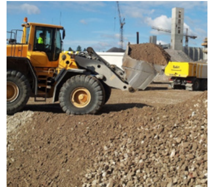
Betoroc BeM II -murskeen lastaus
