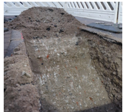
Aukikaivettu Betoroc-murskeella rakennettu katurakenne
