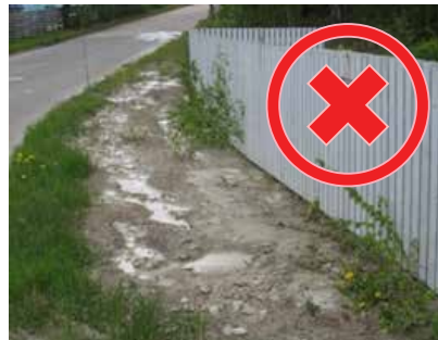
Kuva 7. Pesuveden kiintoaineksen leviämien tontin rajojen ulkopuolella ei vastaa ohjeistusta.
